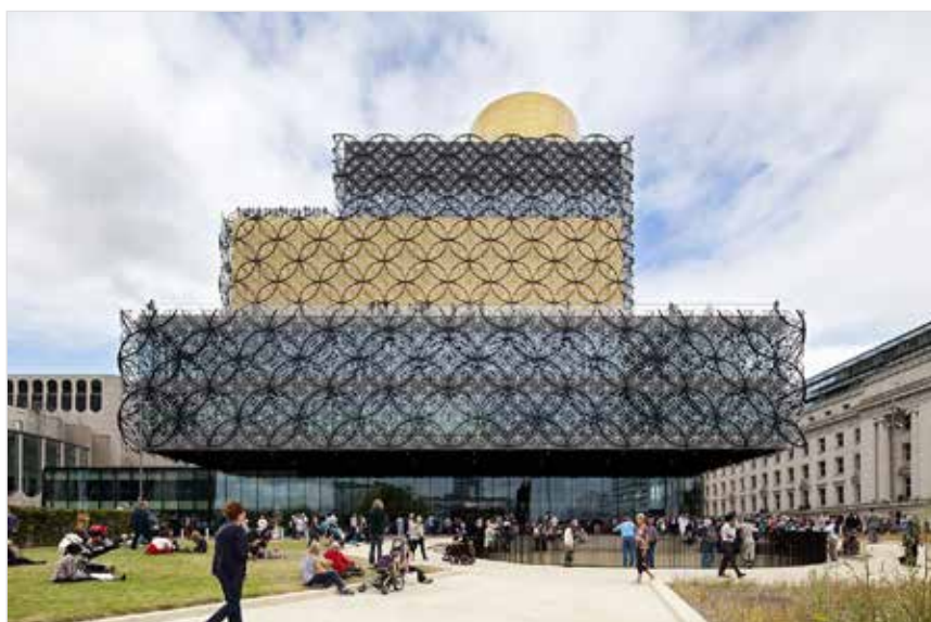
Biblioteca Pública de Birmingham. Fuente M8scho vía Wikimedia.
